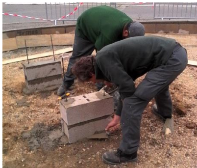
Construction des plots en parpaings qui serviront de supports aux roues de la charette.
