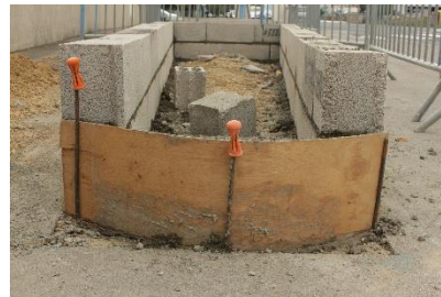
Construction de la jardinière numéro 2.
