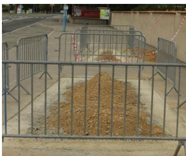
Préparation du terrain, par le découpage du bitume ✚ et le terrassement ✚ du sol.
