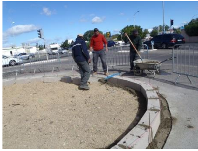
Pose du premier rang de parpaings.
