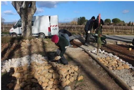
Les galets blancs et marron ont été acheminés sur le chantier.
