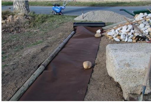
Pose d'un géotextile* sur la parcelle qui empêchera la remontée des adventices*.
