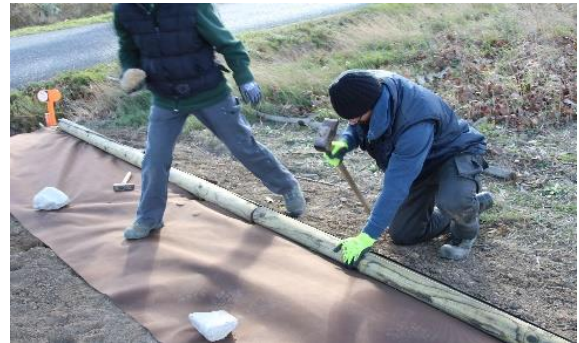
Pose des rondins de bois autour de la parcelle pour la délimiter. Ils sont fixés au sol avec des fers Tor*.
