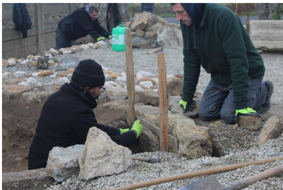
Mise en place des pierres.
